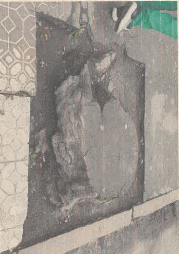
Imágenes de referencia de tocón a retirar
