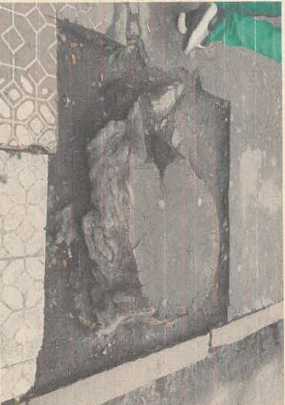
Imágenes de referencia de tocón a retirar
