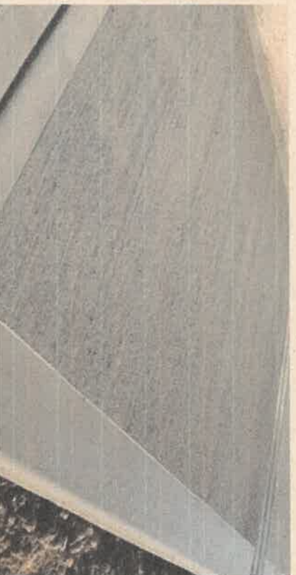
Imagen de referencia de terminación de hormigón peinado
