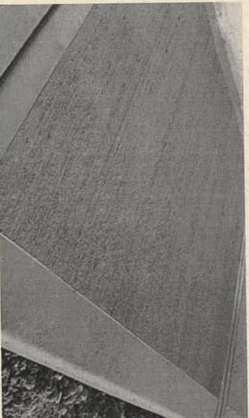
Imagen de referencia de terminación de hormigón peinado
