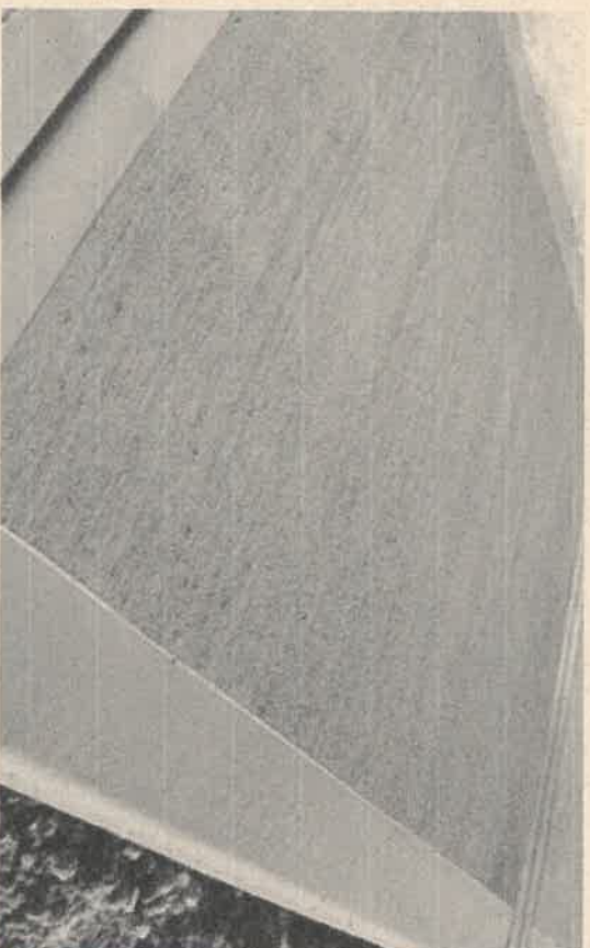
Imagen de referencia de terminación de hormigón peinado
