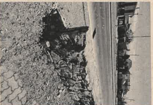
Piedra laja suelta o inexistente en pirca a reparar
