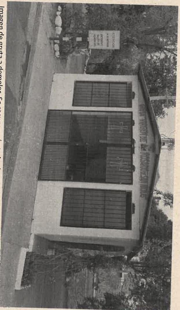
Imagen de gruta a demoler. Se recuperarán todos los materiales (chapas, perfiles metálicos, artefactos eléctricos, etc.) elementos ornamentales carpinterías y rejas existentes
