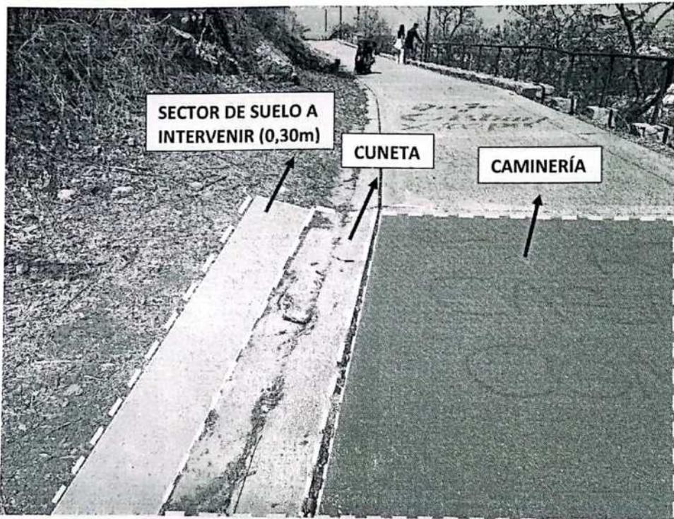
Imagen de referencia de las distintas secciones a distinguir para realizar trabajos de limpieza
