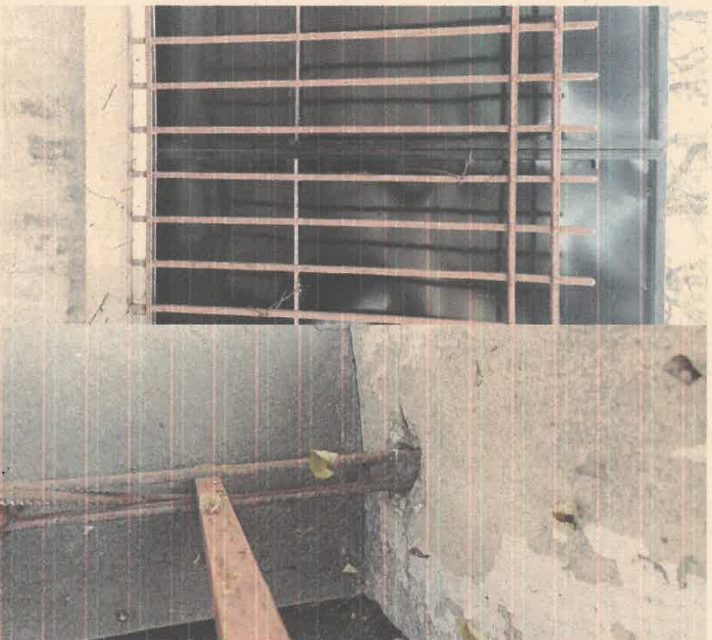
Imagen del diseño de las rejas y modo de anclaje
