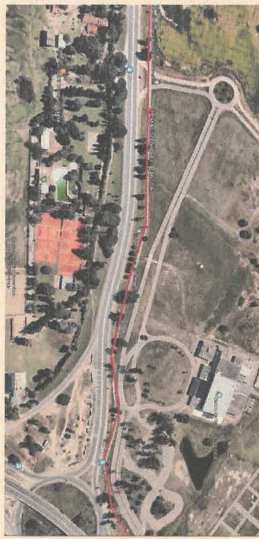
1) ESTACIÓN N°1: Se encuentra sobre Av. Banichik a metros de la entrada al Corsodromo
