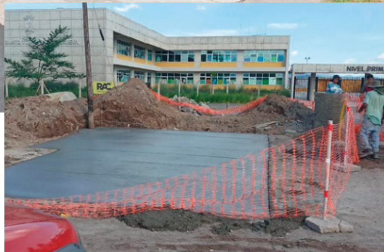
Obras en barrio San Remo.
