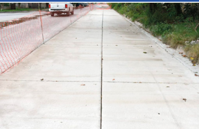
Bacheo de hormigón en Villa Palacios.
