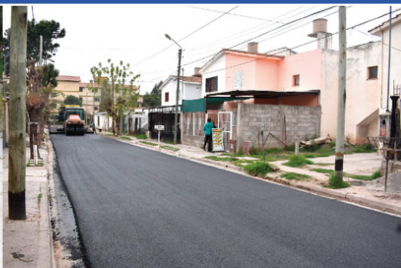
Obras en barrio Limache.
