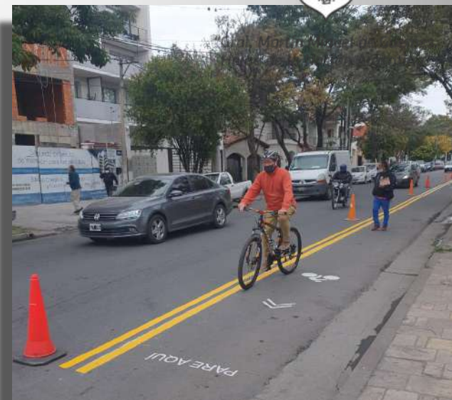
Ciclovía propuesta en ejecución sobre Av. Belgrano
